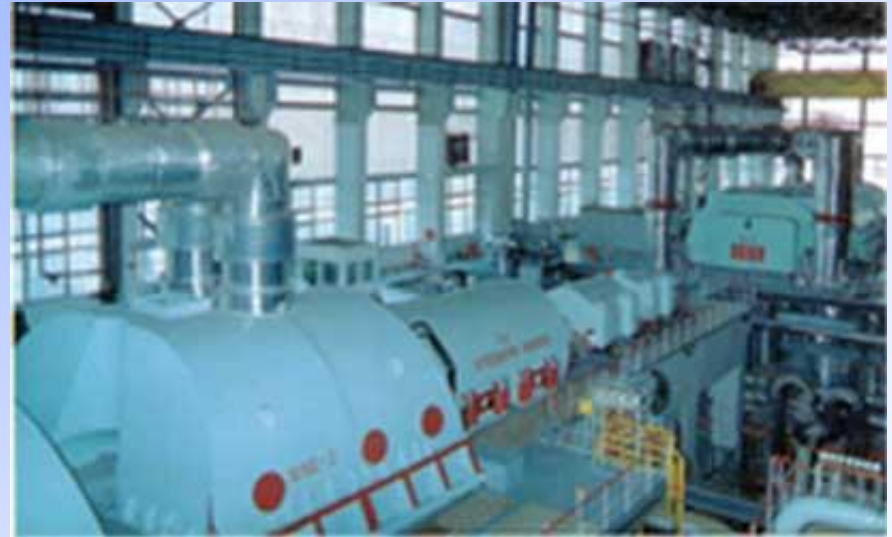
Turbina 1000 MWe, EJ Nowoworoneż
